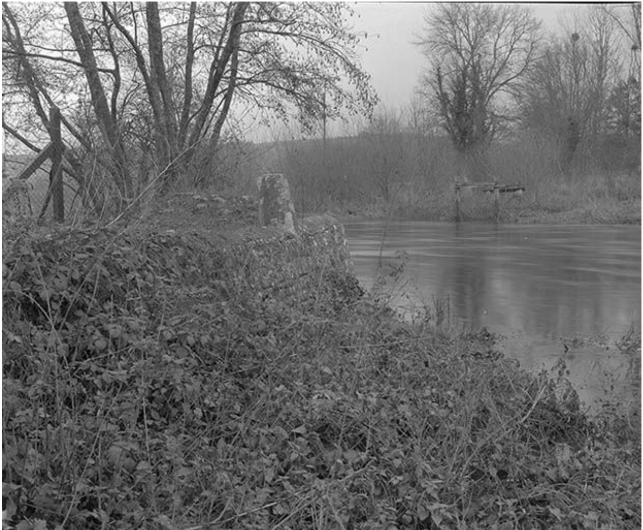
Vestiges de la passerelle. La culée ouest.
