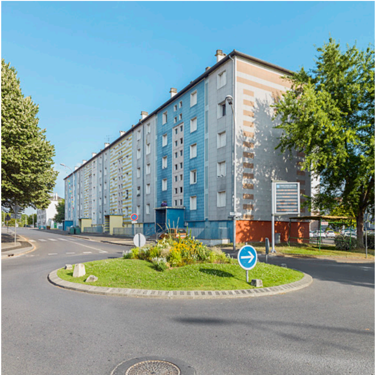
Bâtiment I, façade antérieure.
