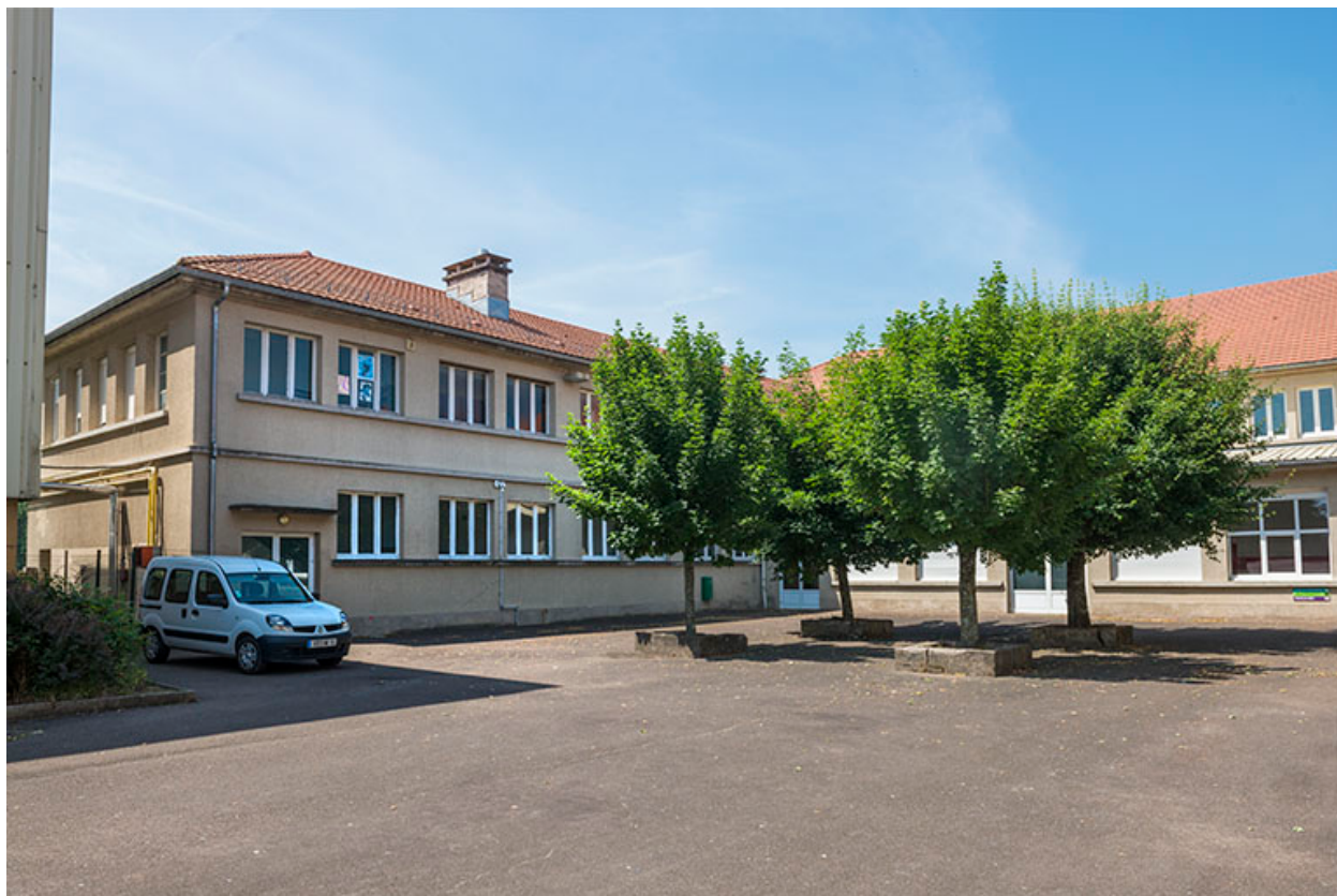
Angle sud-ouest de la cour.
