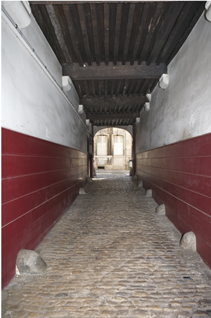
Passage cocher, depuis la cour.
