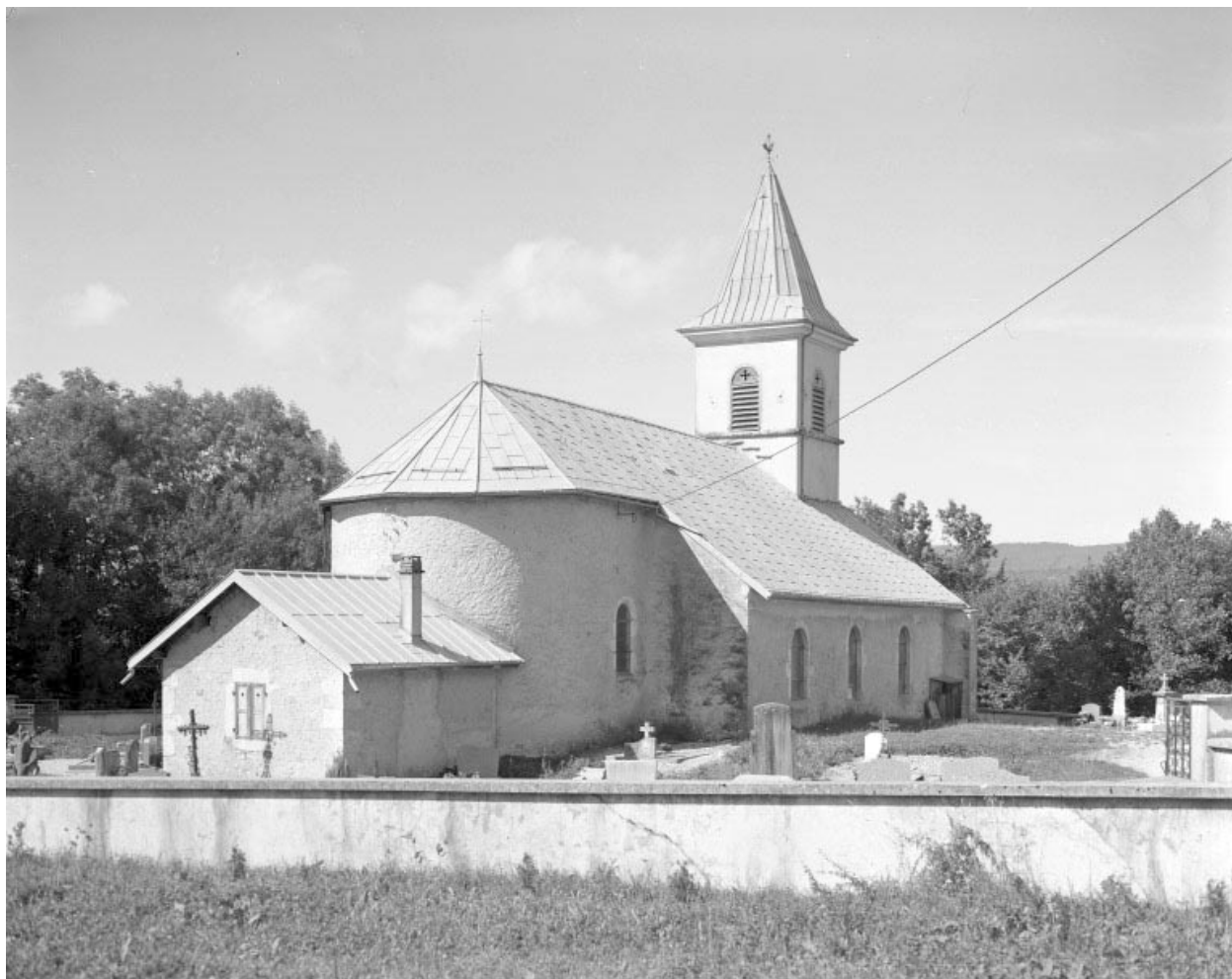
Extérieur : abside et face nord.
