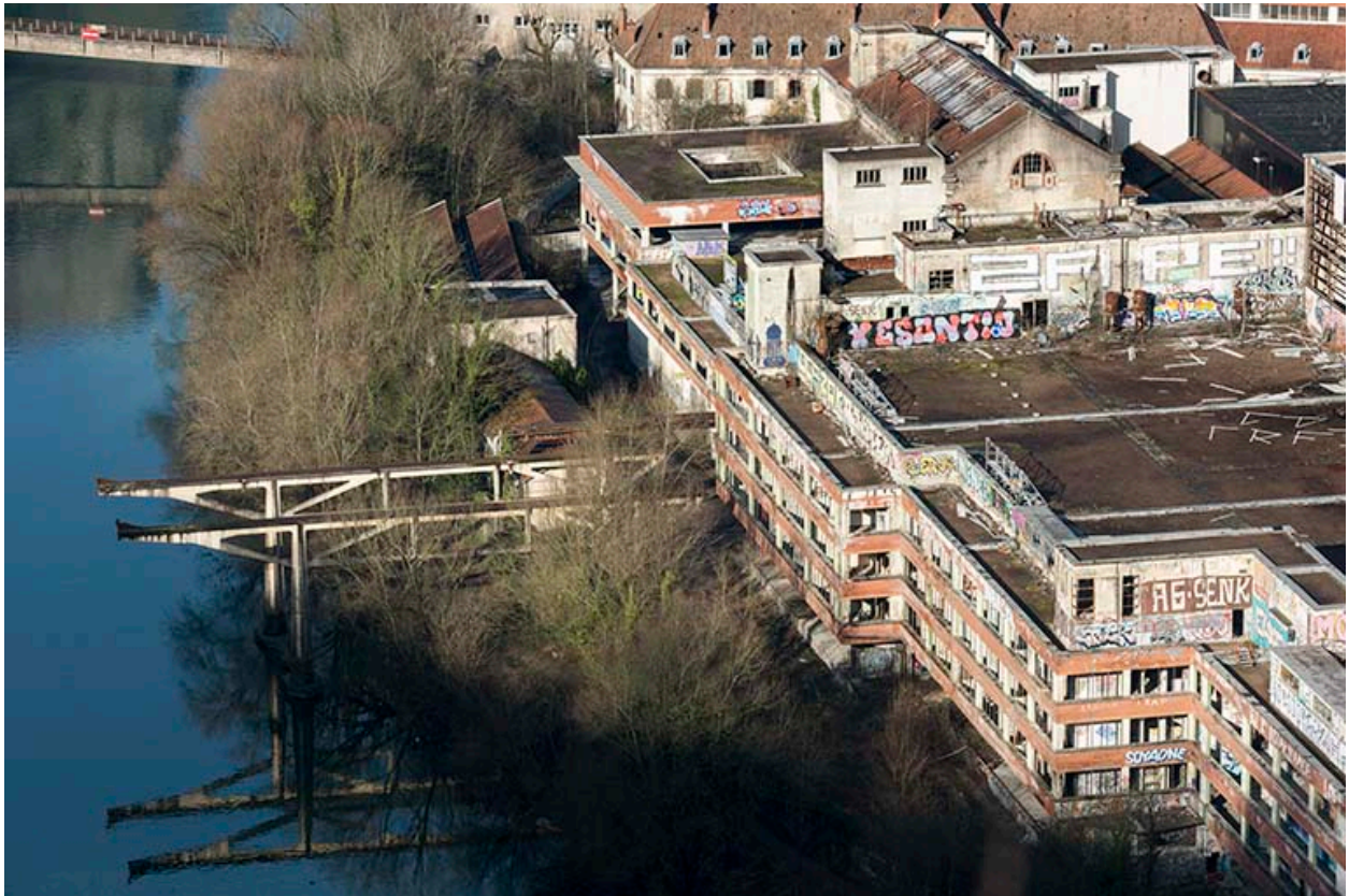
Etat en 2016. Usine A : vue plongeante sur le portique en béton du pont roulant.
