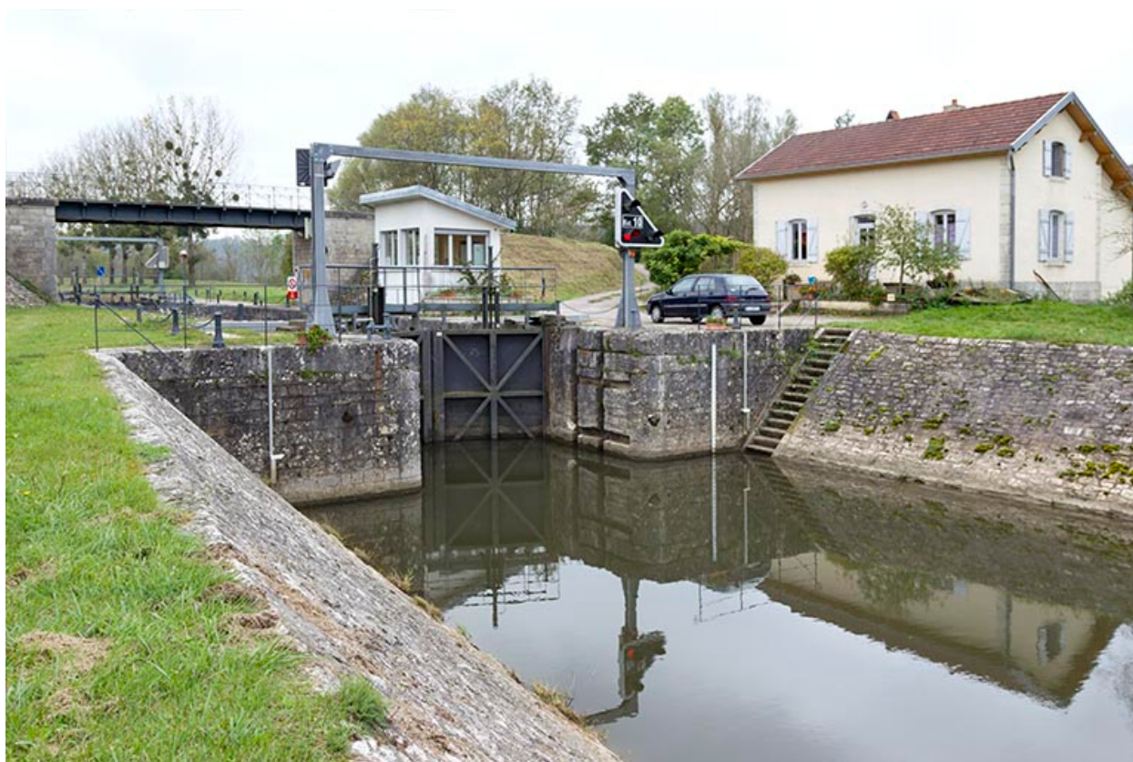
Vue aval de l'entrée du sas.
