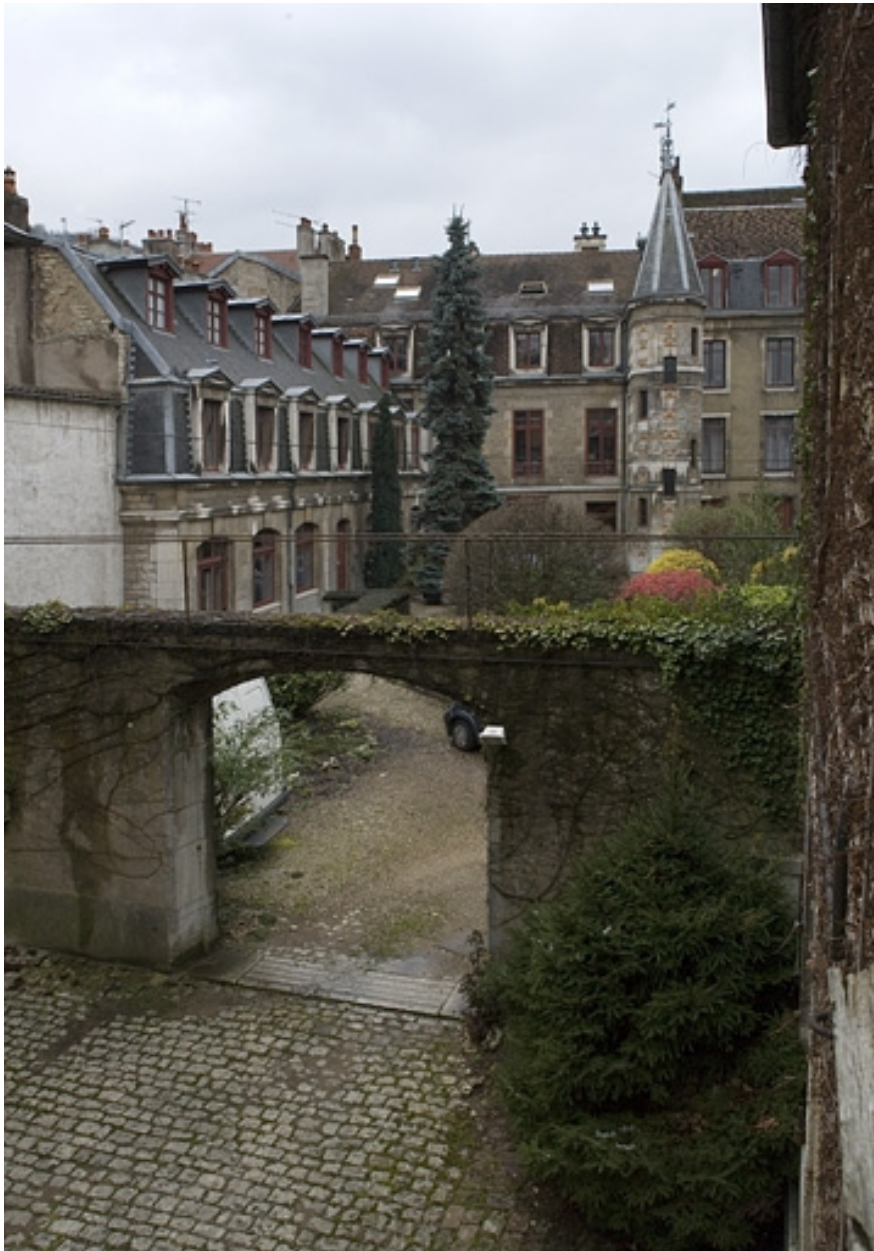
Vue d'ensemble des bâtiments depuis la cour des communs.
