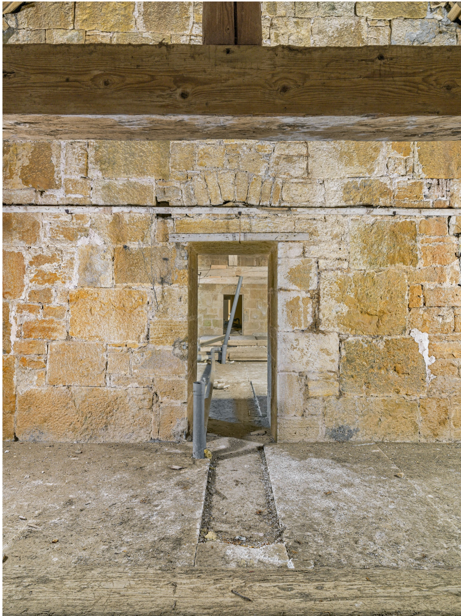
Caserne U, grenier : vue traversante.
