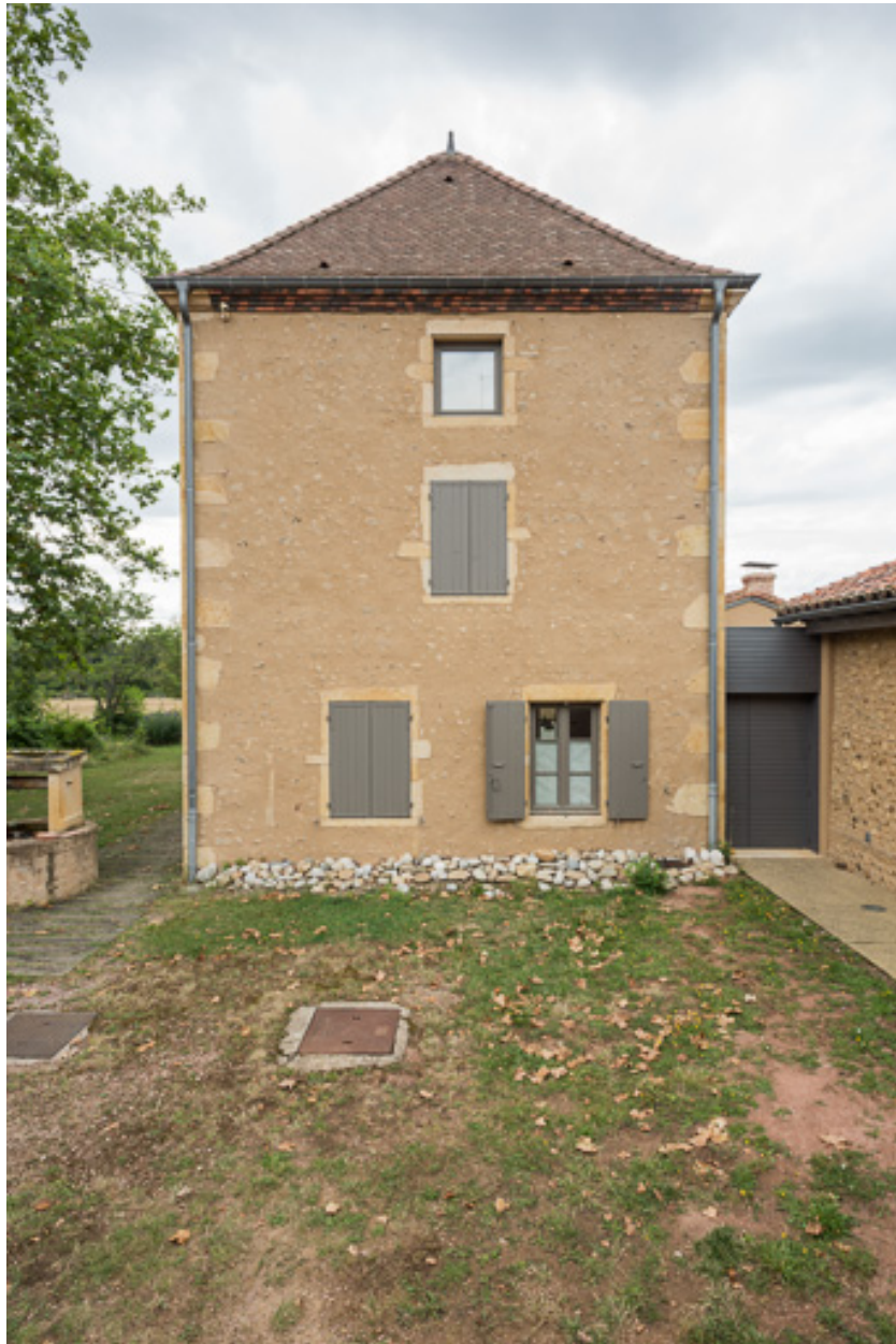
Façade latérale est de la maison
