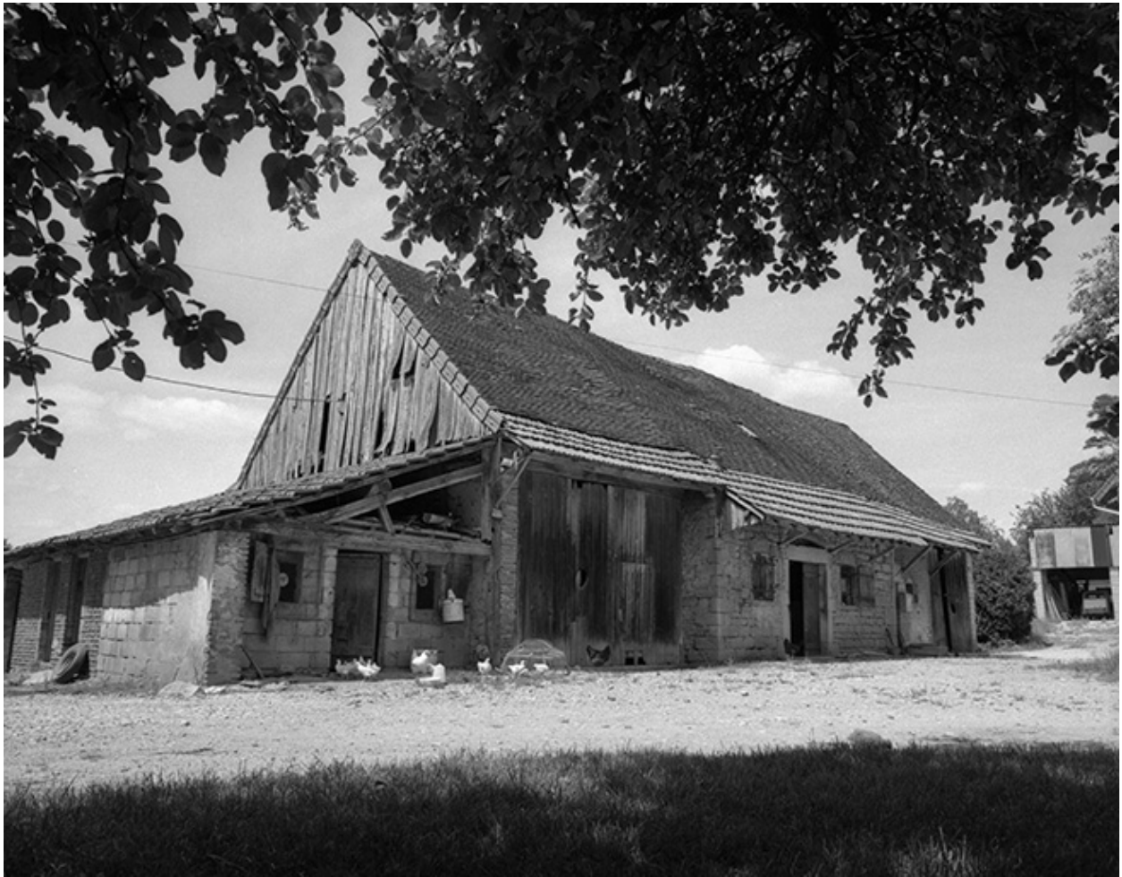
Partie agricole d'une ferme.
