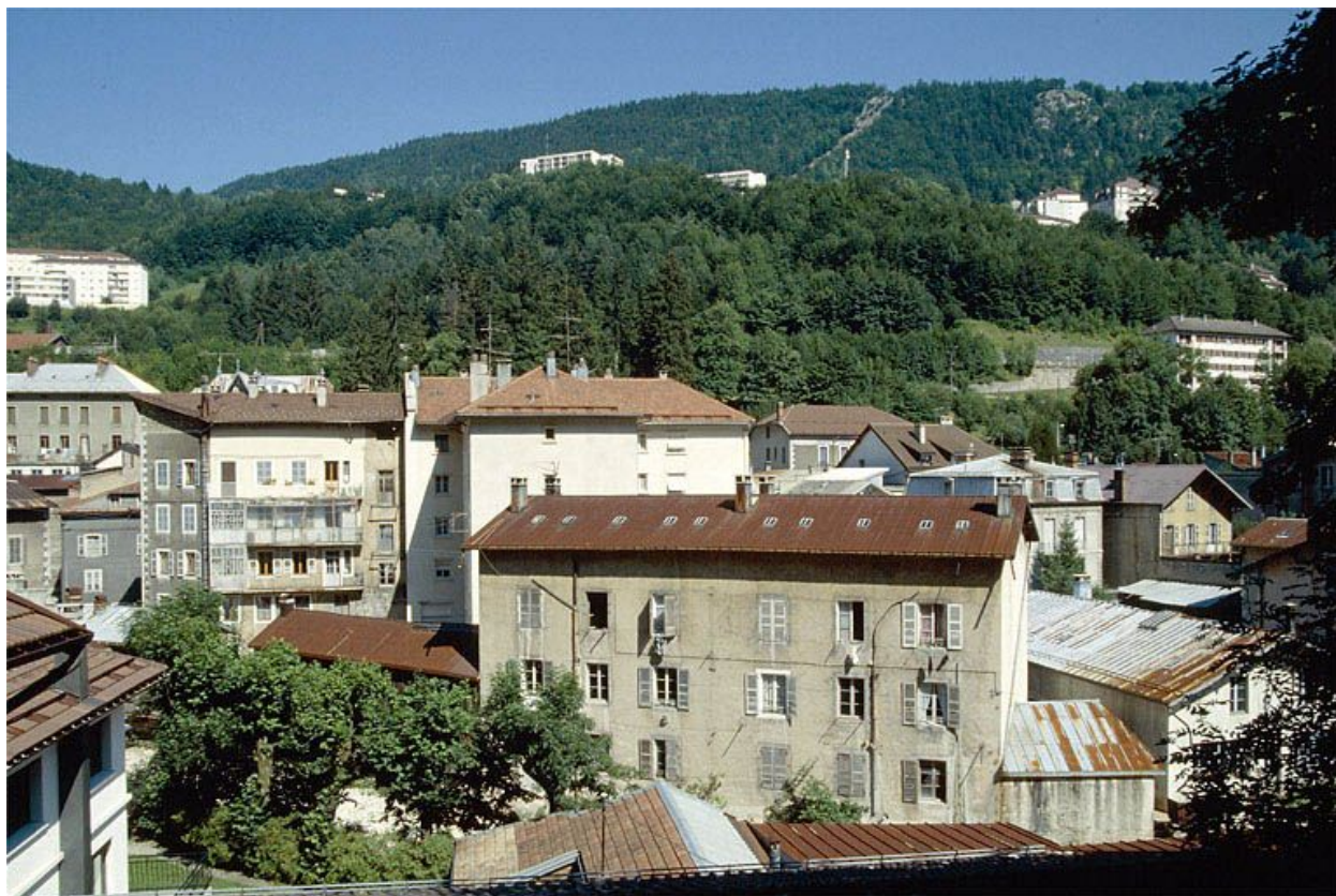
Immeuble et remise : façade sur la Bienne.
