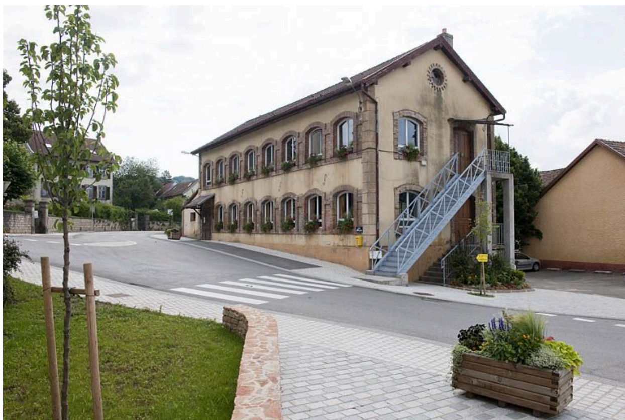
Usine Marchand puis Rigoulot, à Vandoncourt.
