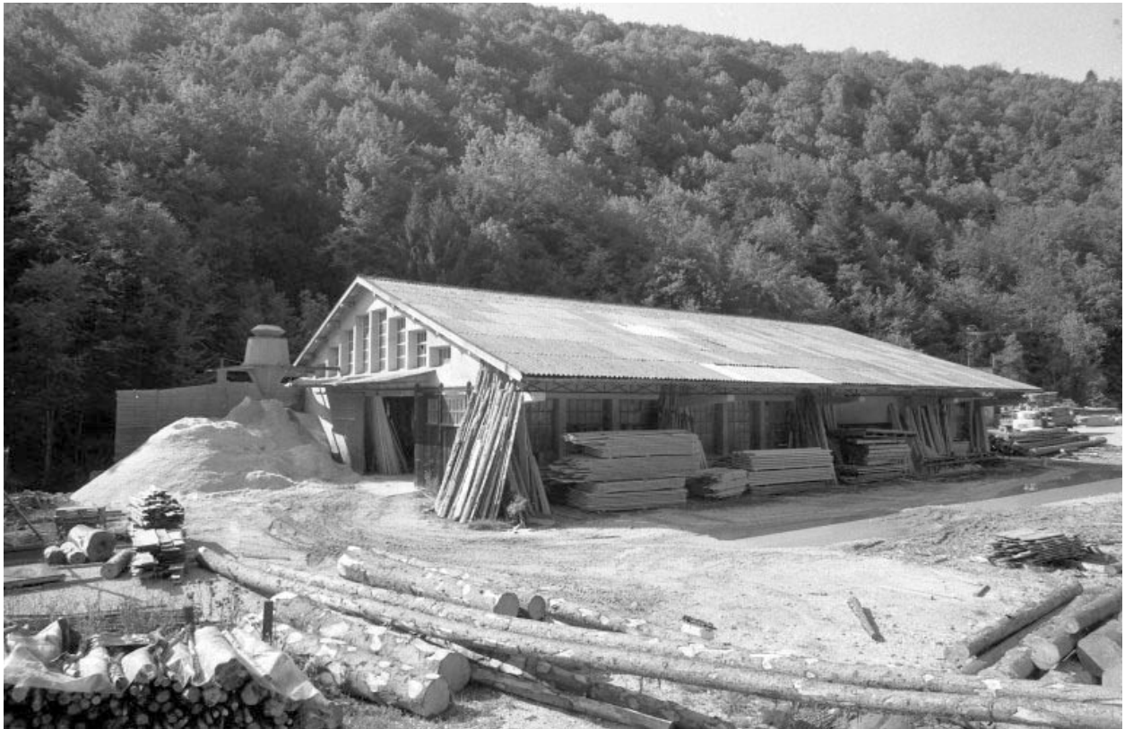
Façade latérale gauche de la scierie.
