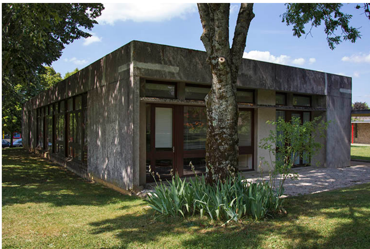
Angle sud-ouest de l'administration.
