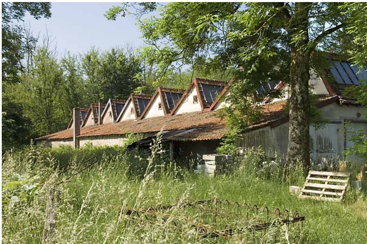
Pignons ouest de l'atelier de fabrication.
