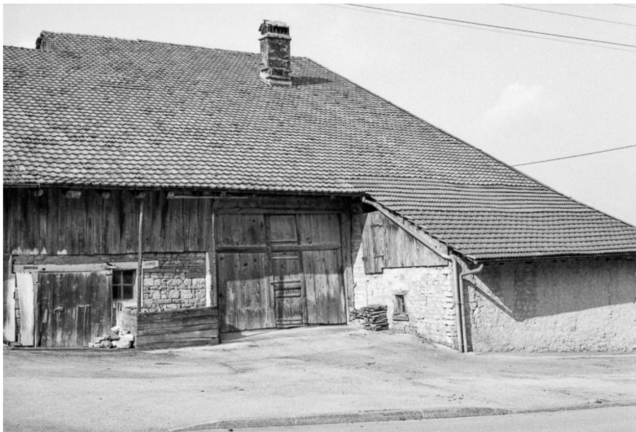
Ferme cadastrée 1962 E 182 : façade latérale droite (?).
