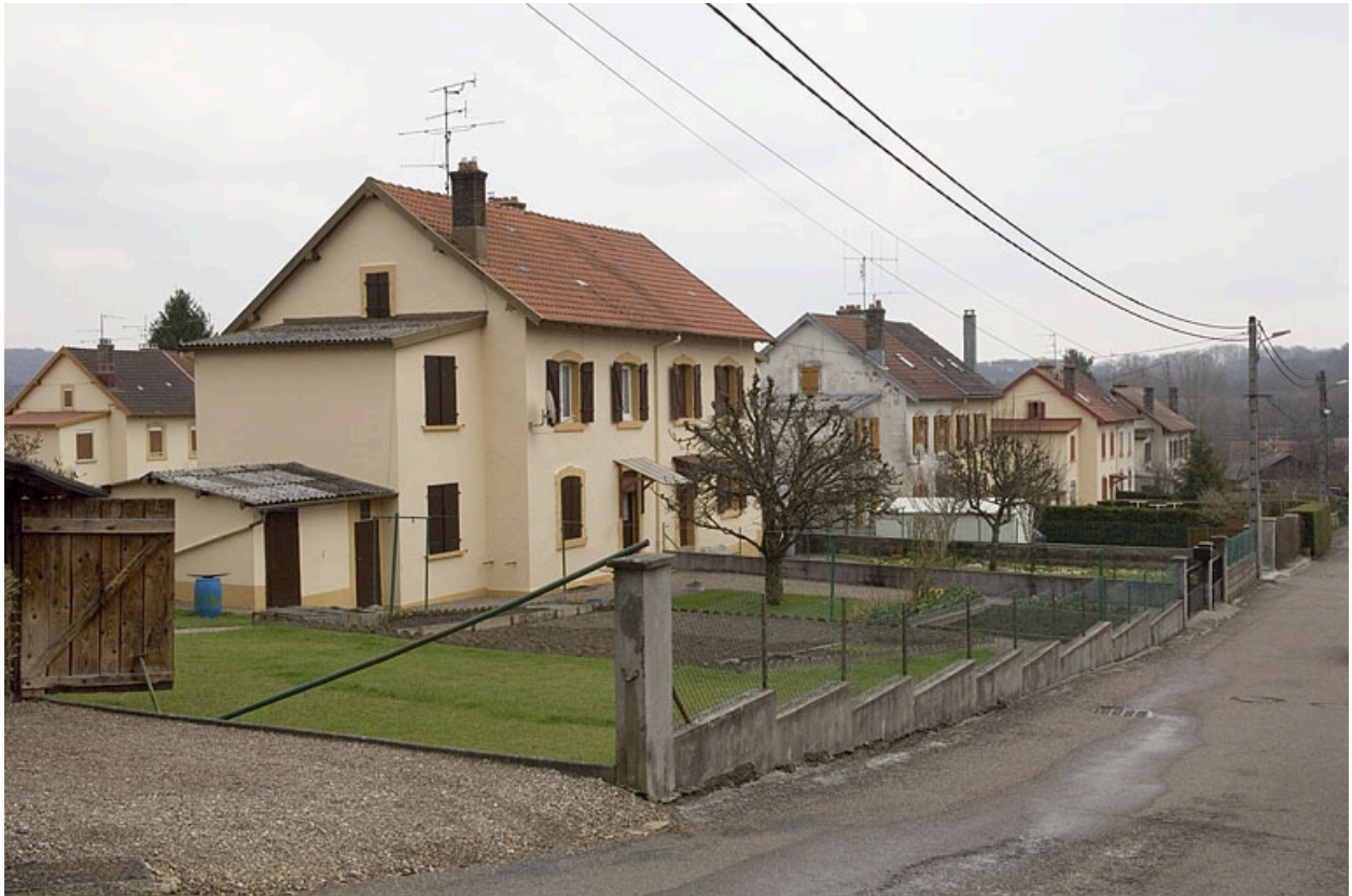
Maisons ouvrières rue de Thionville.
