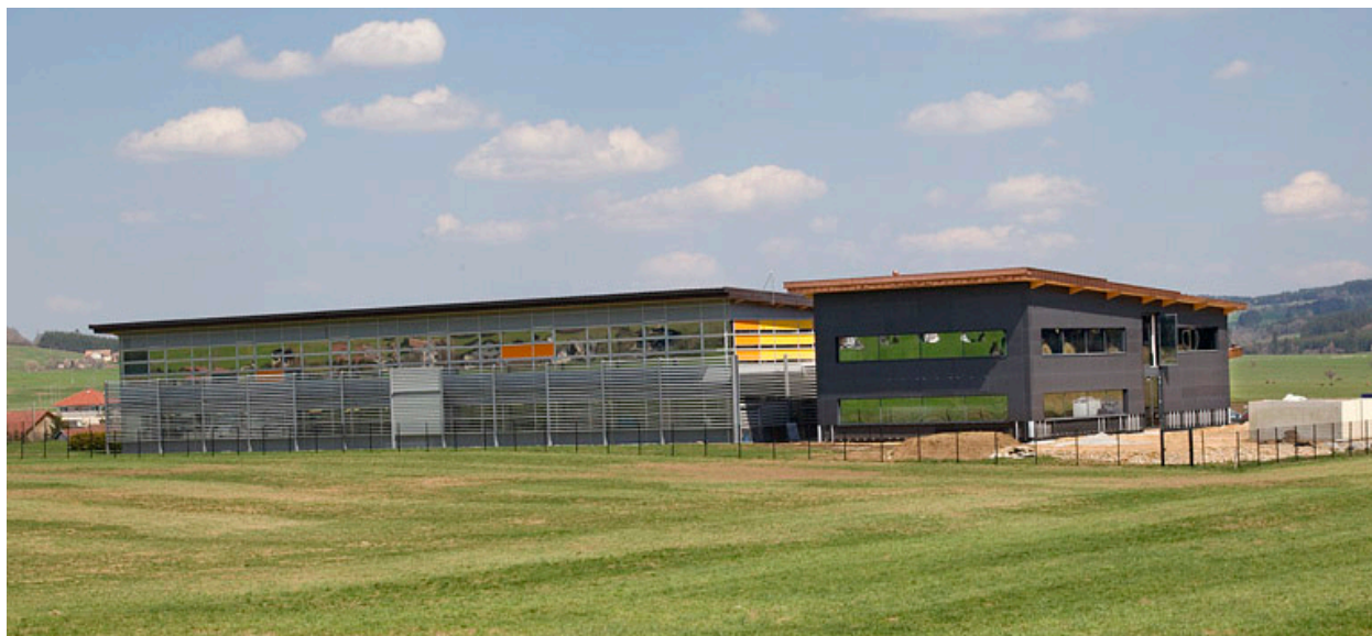
Façades postérieure et latérale gauche.
