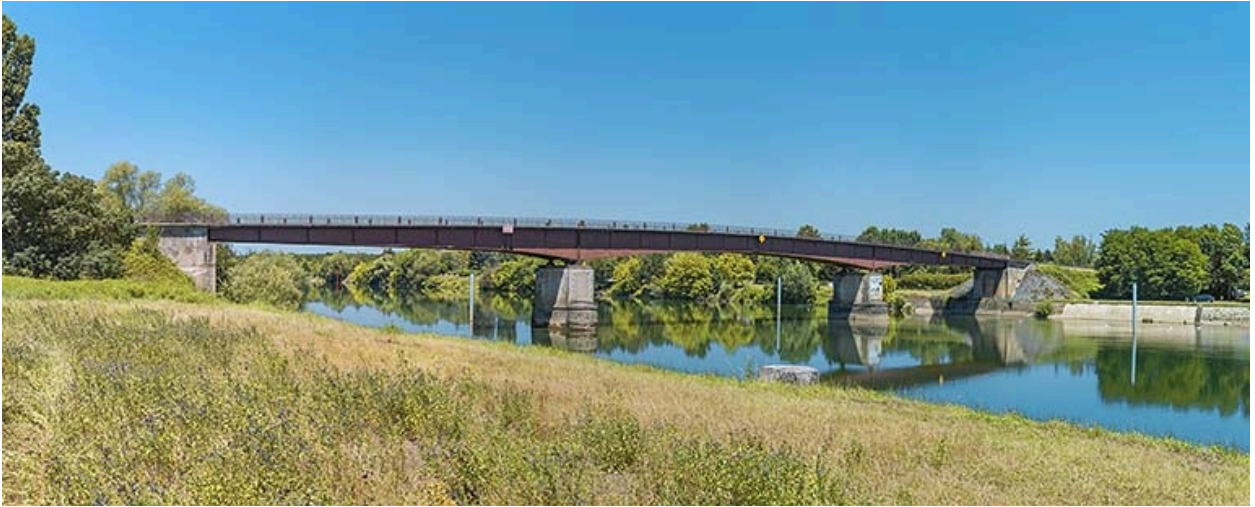
Le pont de Bragny vu d'amont.
