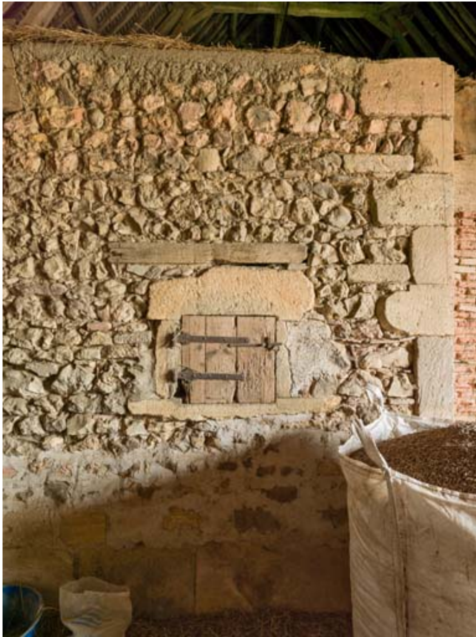
Ouverture (dite feuron) dans le mur de séparation entre l'étable et la remise.
