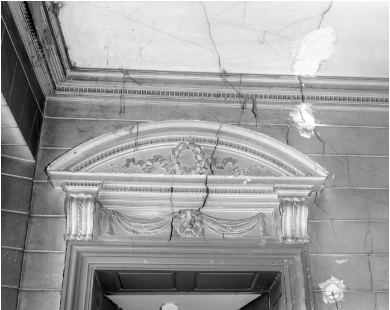
Intérieur : escalier d'honneur, porte droite sur le palier : détail du fronton.
