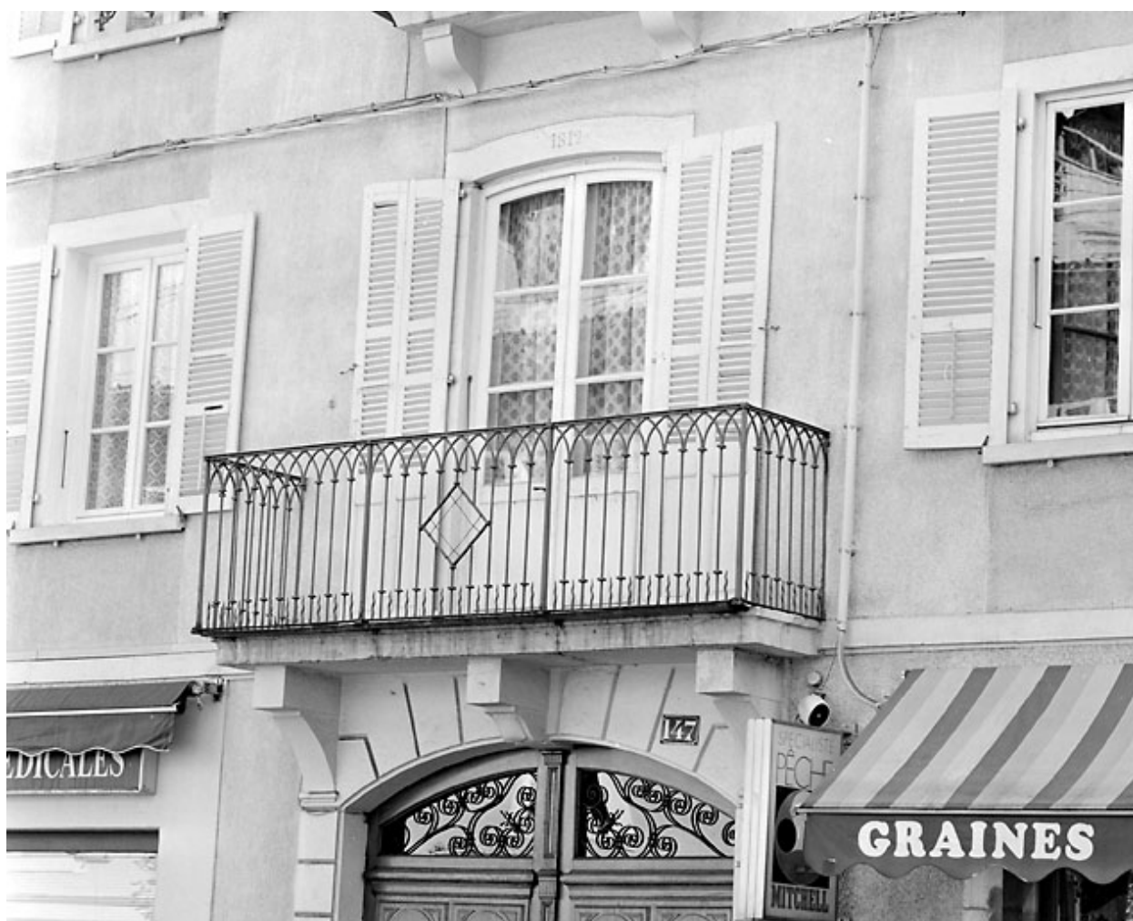
Porte-fenêtre et balcon du premier étage.
