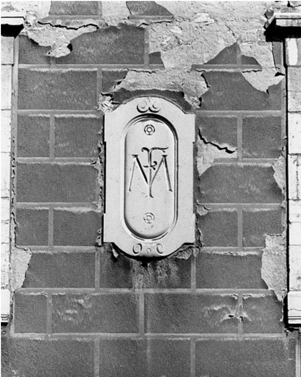
Logis secondaire : façade antérieure, détail du médaillon droit.
