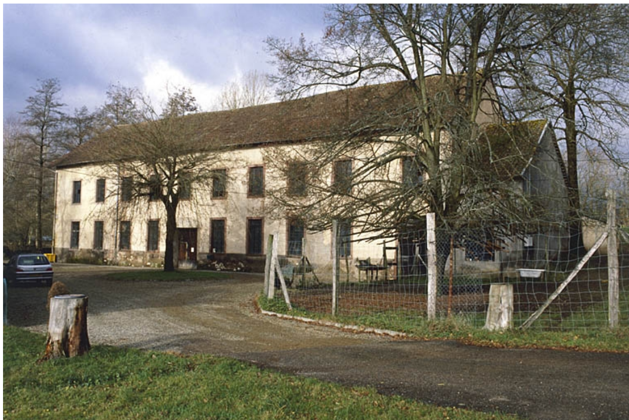
Façade antérieure de l'atelier de fabrication.
