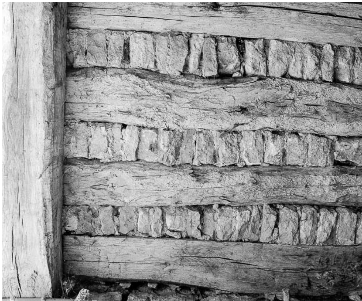
Plafond de la cave : hourdis de pierre.
