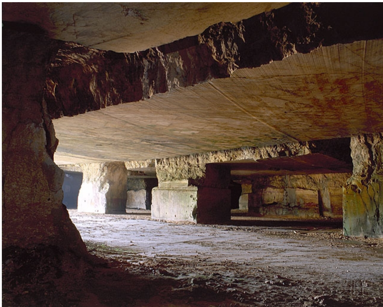
Intérieur, partie centrale, près d'une entrée.
