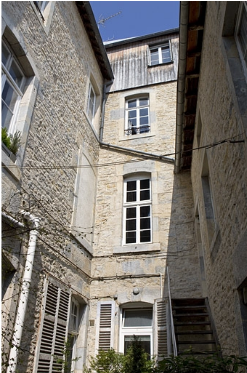
Vue des façades donnant sur l'ancienne basse-cour.
