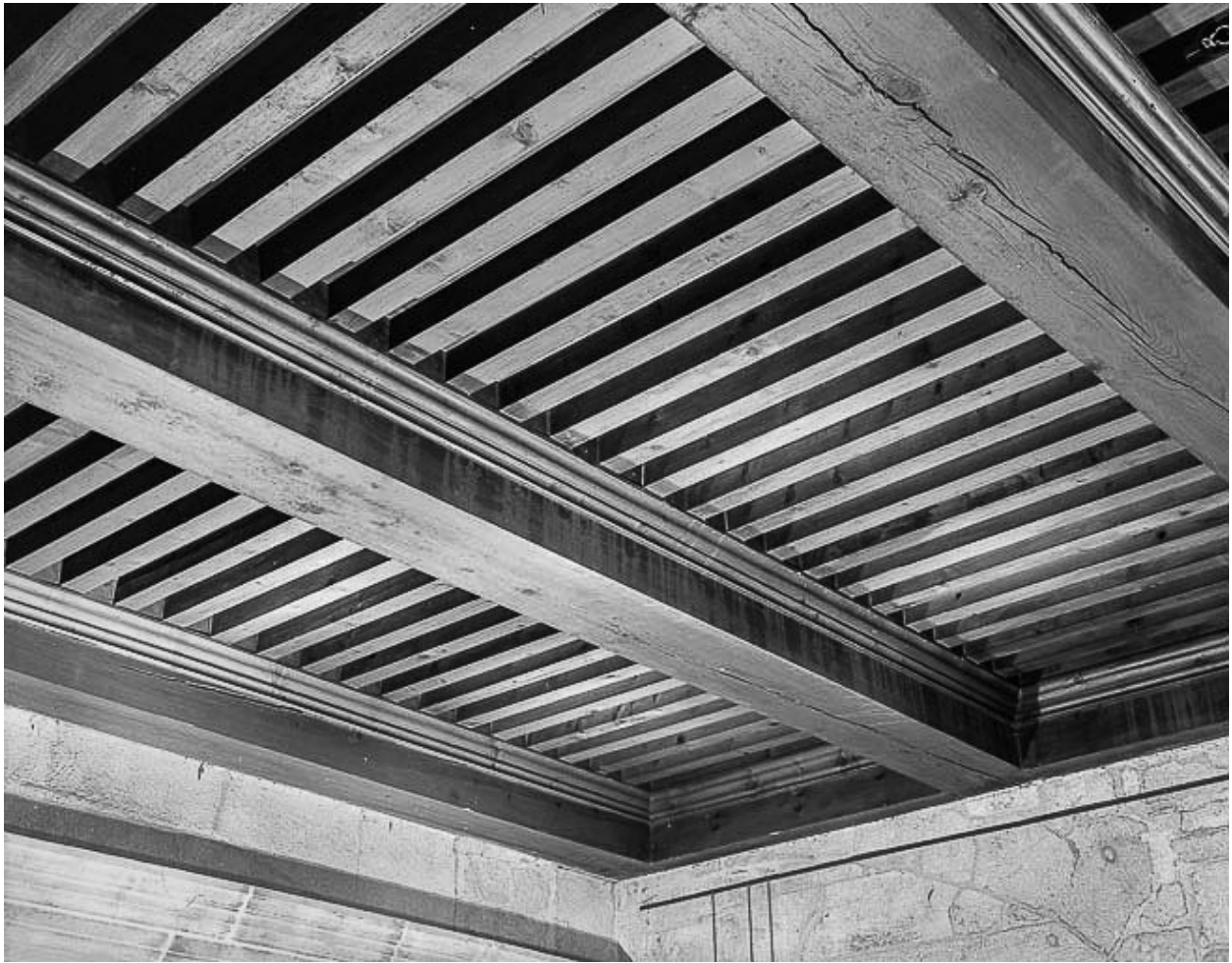
Vue du plafond.
