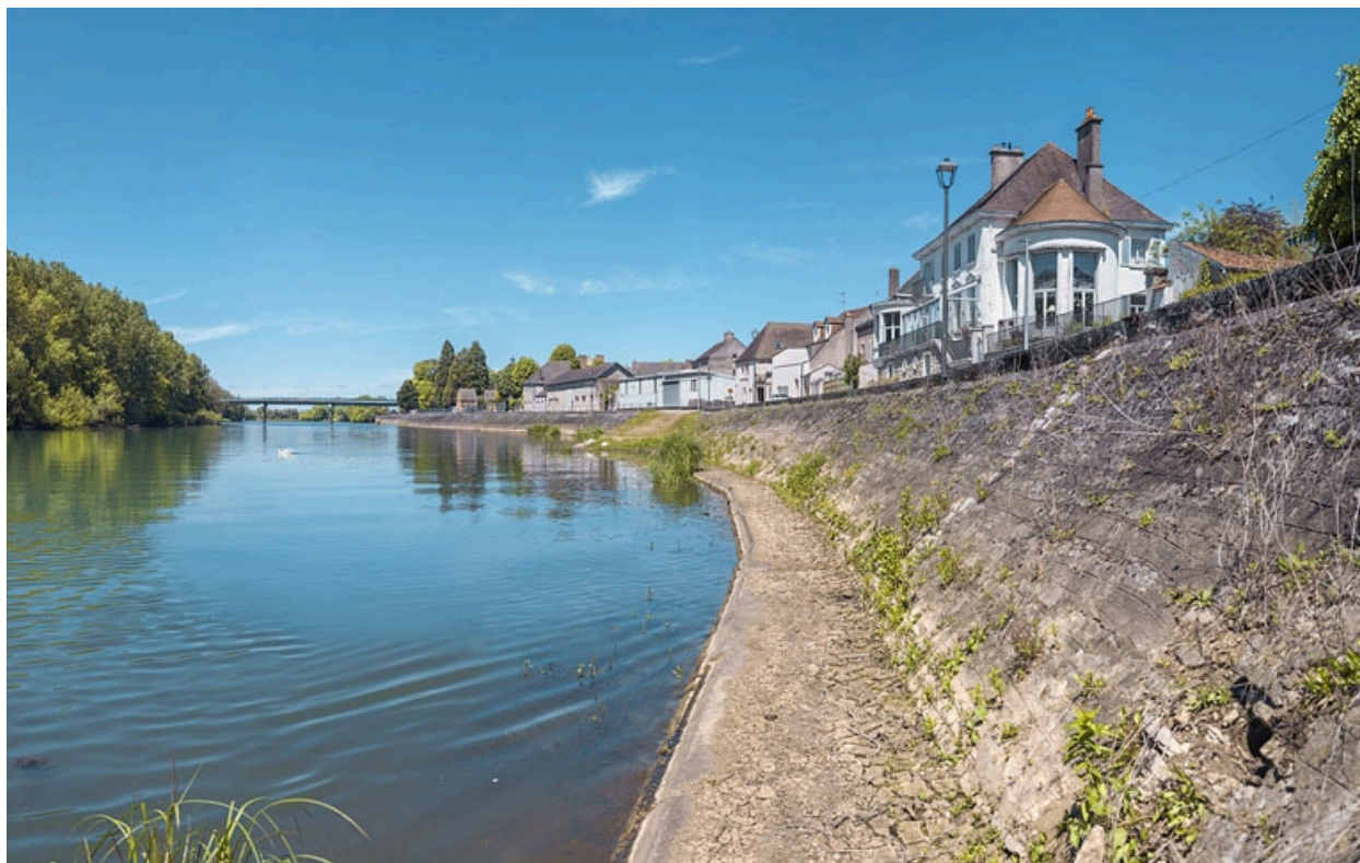
Quais en aval du pont routier.
