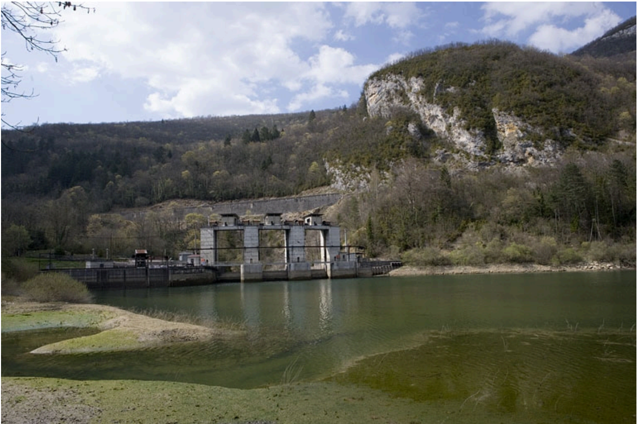
La voie et la vallée de la Bienne au barrage d'Étables (Saint-Claude). Vers le PK 077.100.
