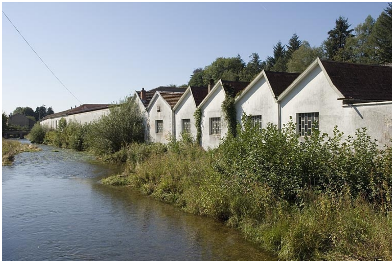
Magasins industriels le long de la Combeauté.
