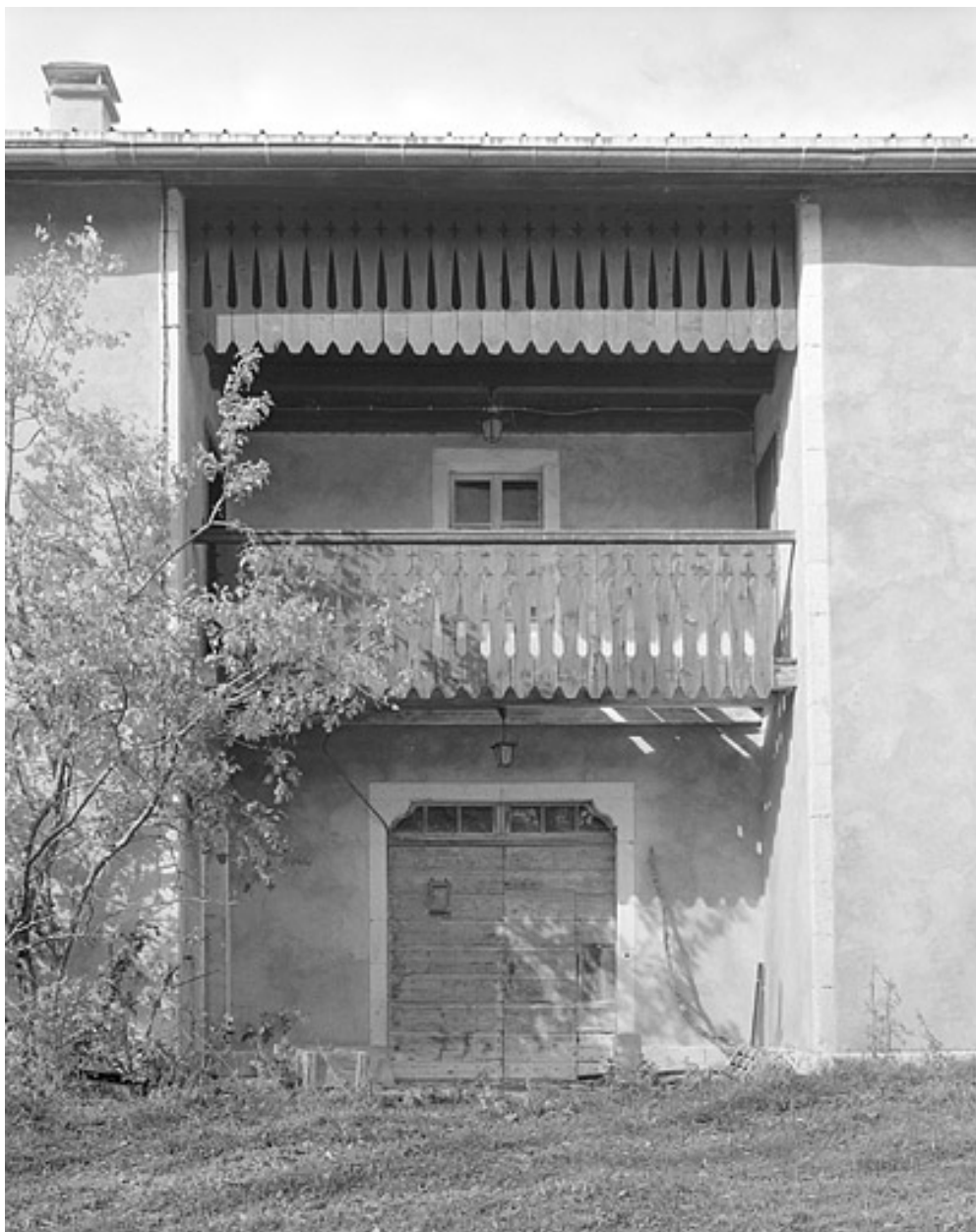
Galerie centrale sur la façade antérieure.
