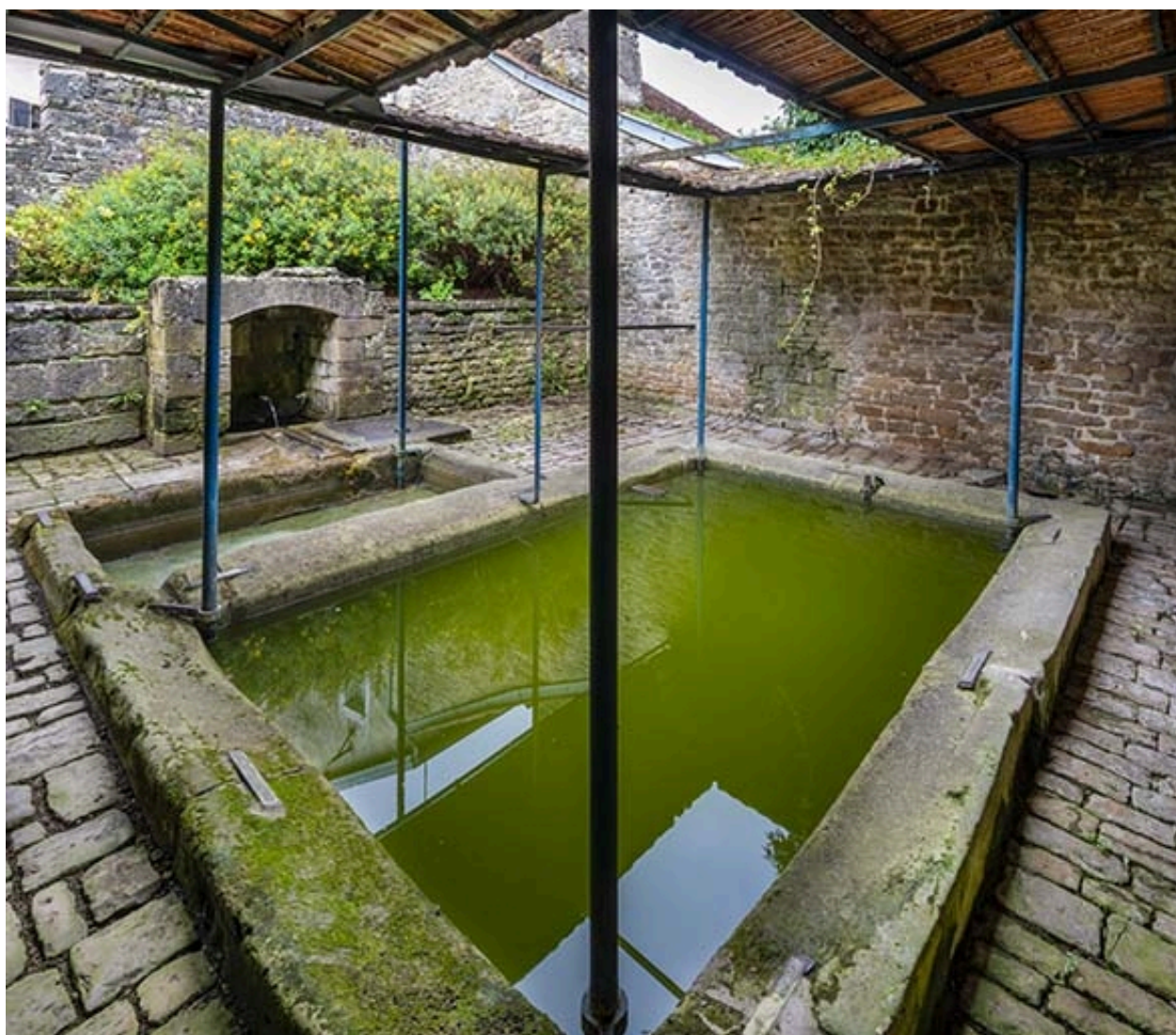
Vue intérieure des bassins.
