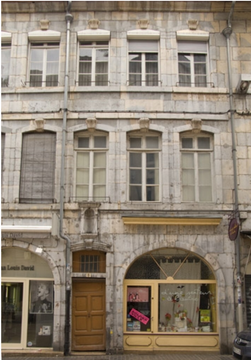
Vue d'ensemble de la façade antérieure du logis principal, de face.
