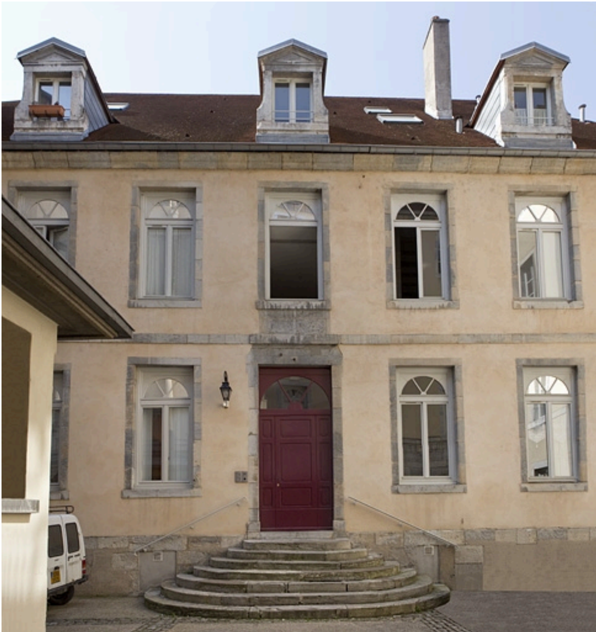
Maison entre les deux cours : façade postérieure, de face.
