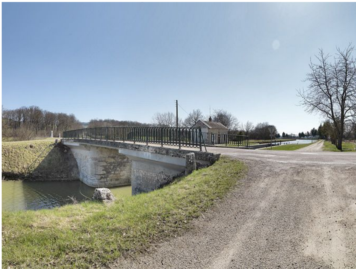
Le pont vu d'aval.
