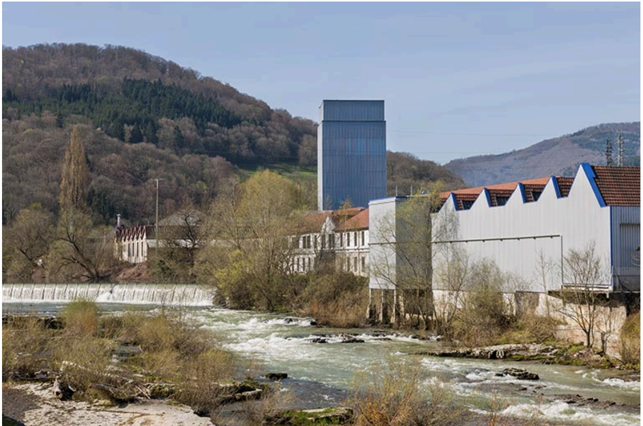
Usine rive gauche. Vue depuis le pont.
