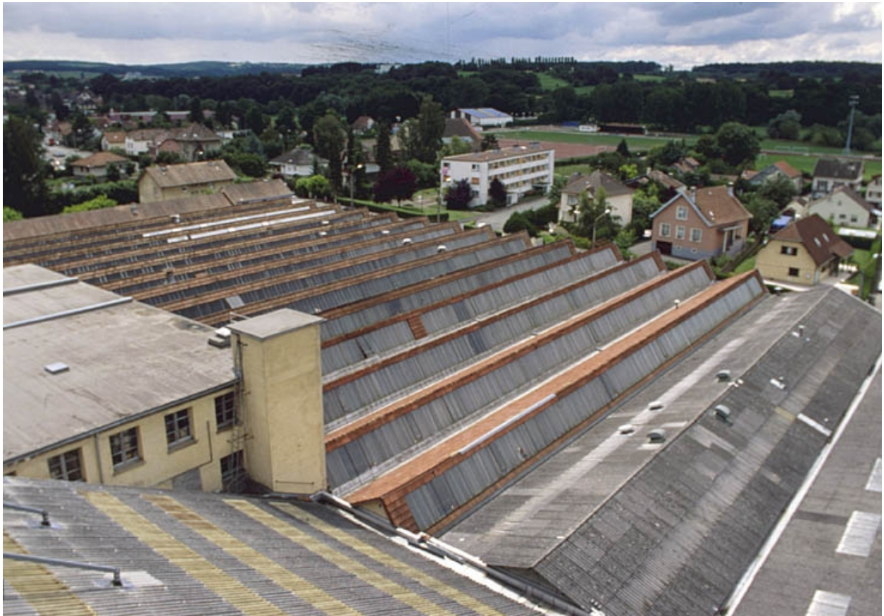
Toitures des ateliers de fabrication en rez-de-chaussée.
