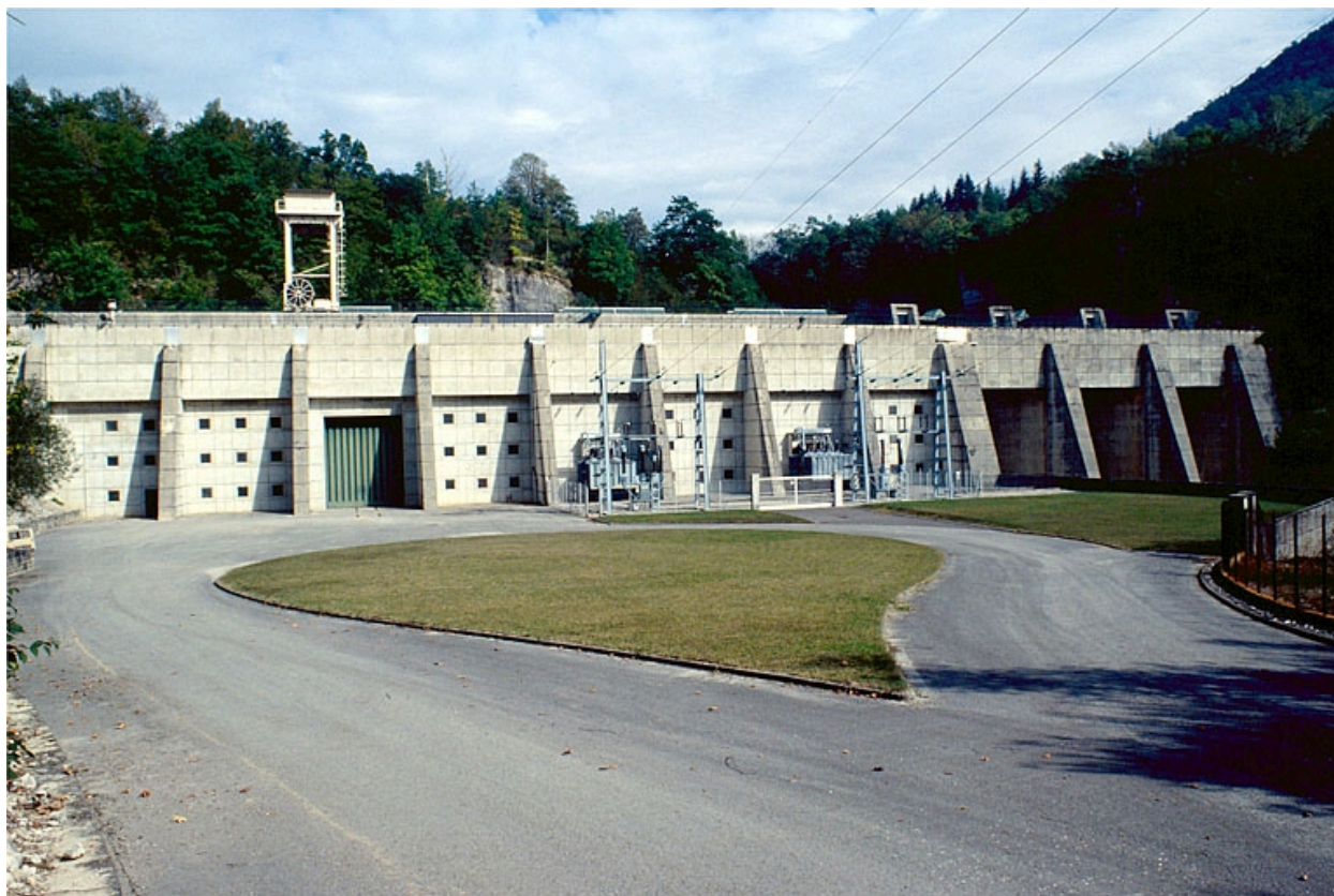
Centrale hydroélectrique du Saut-Mortier, Cernon.
