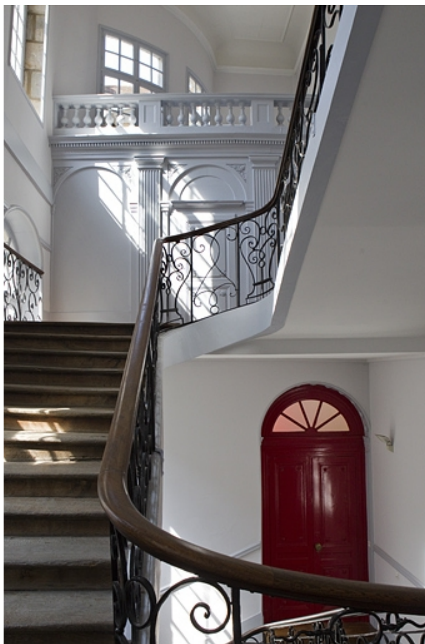
Escalier : détail des volées supérieures.
