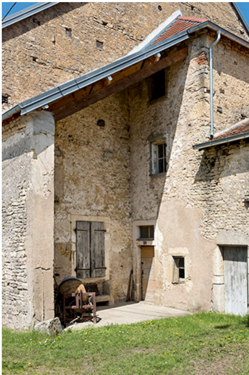
La partie abritée de la façade antérieure.
