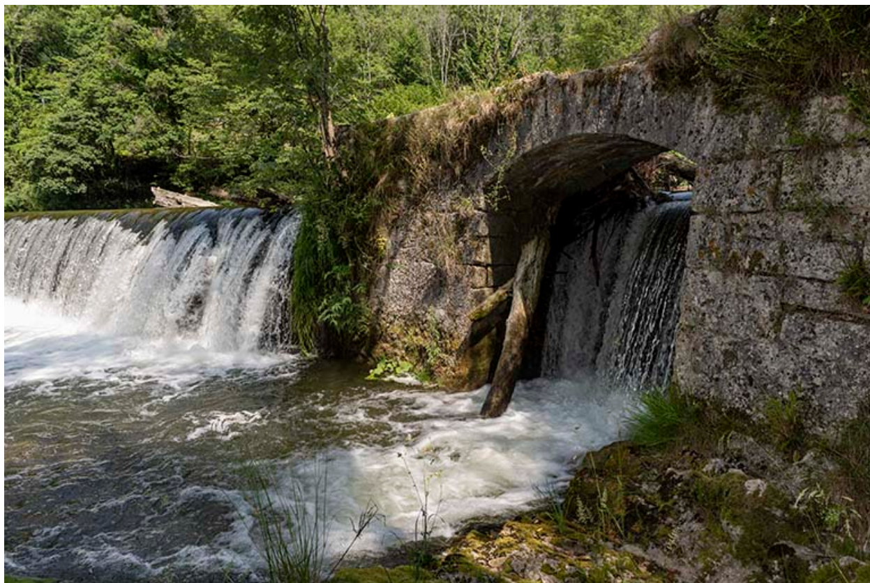
Extrémité du barrage rive droite.
