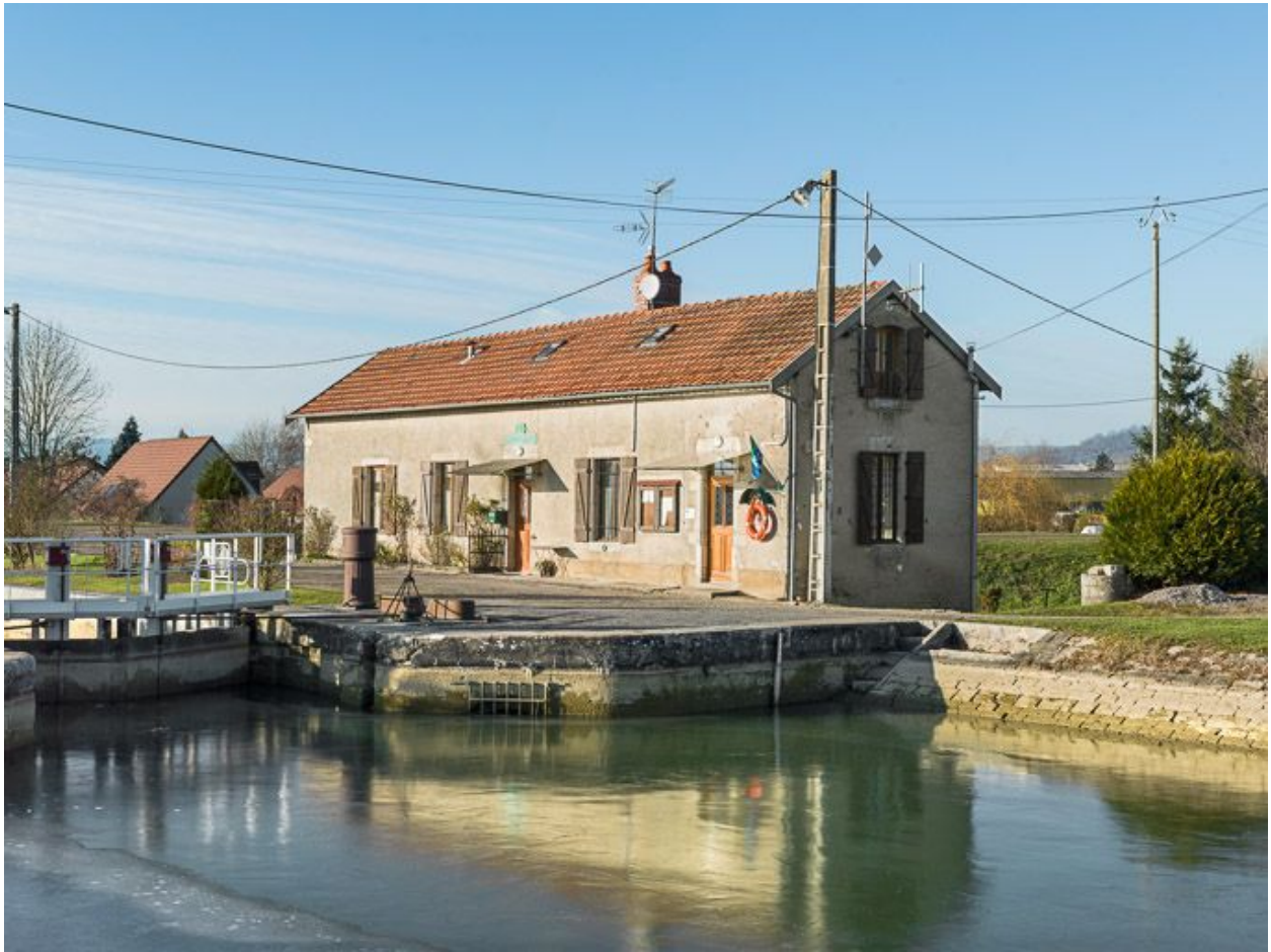
Vue de 3/4 de la maison éclusière.
