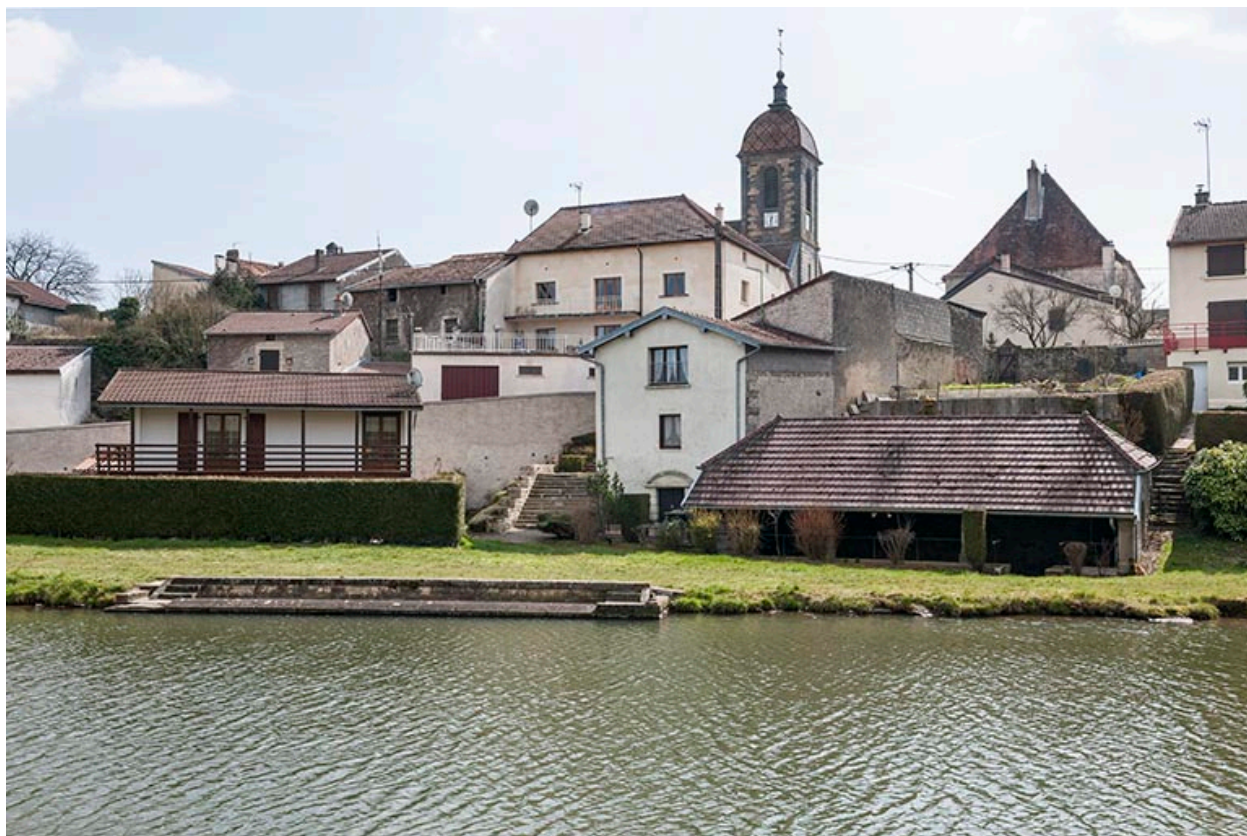
Le lavoir situé le long du canal.
