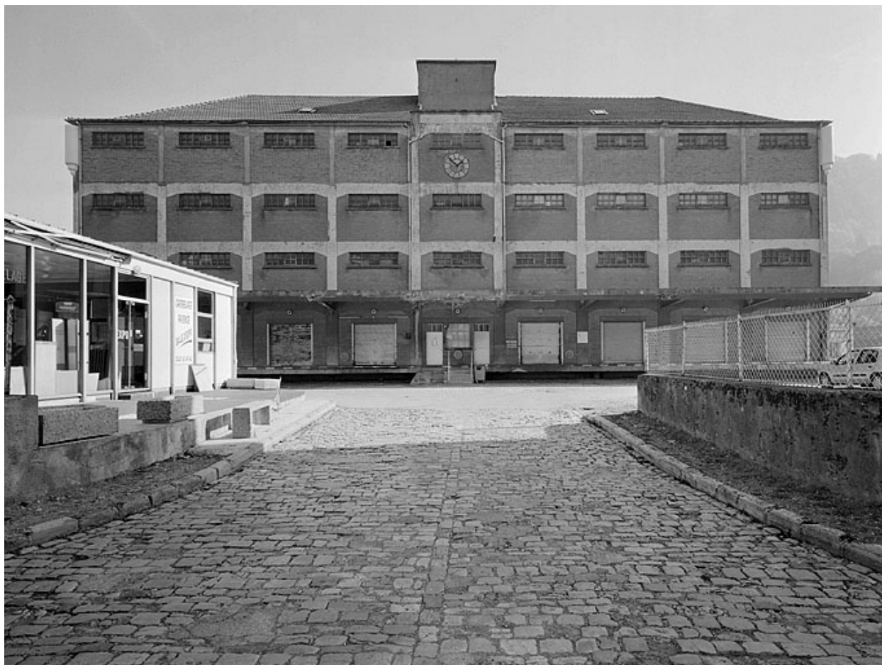
Entrepôt : façade antérieure.
