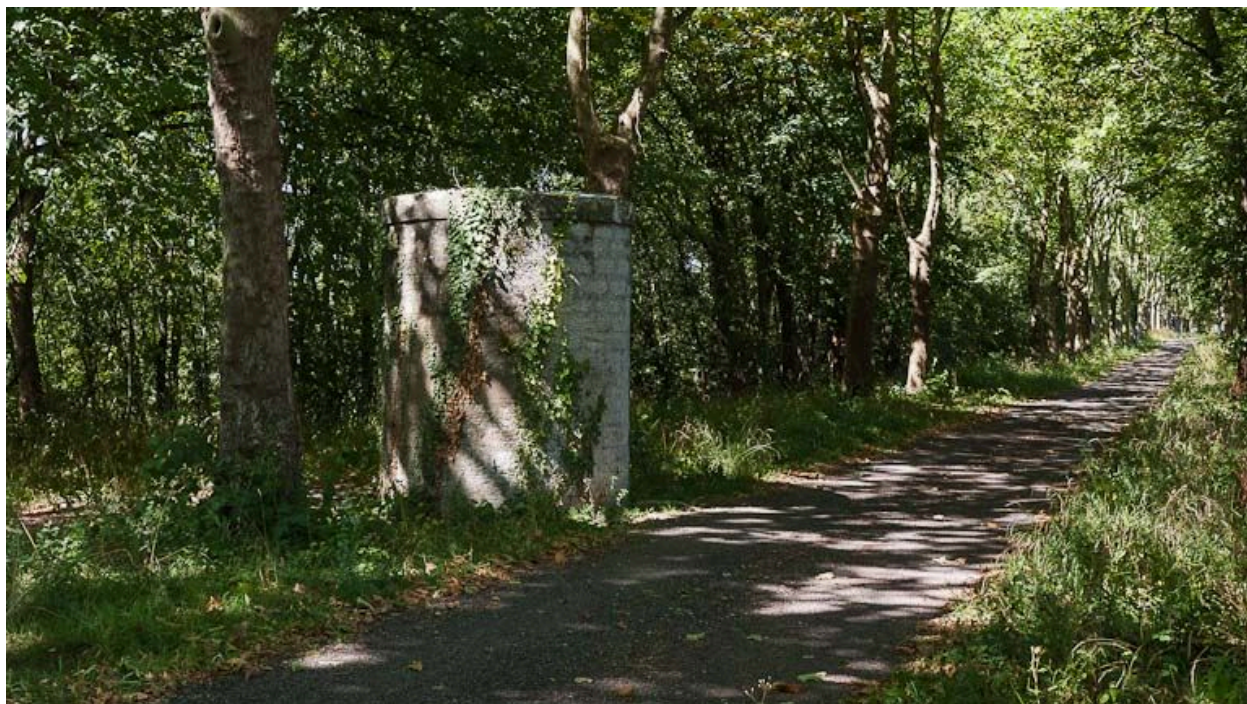
Vue d'un puits d'aération du tunnel.
