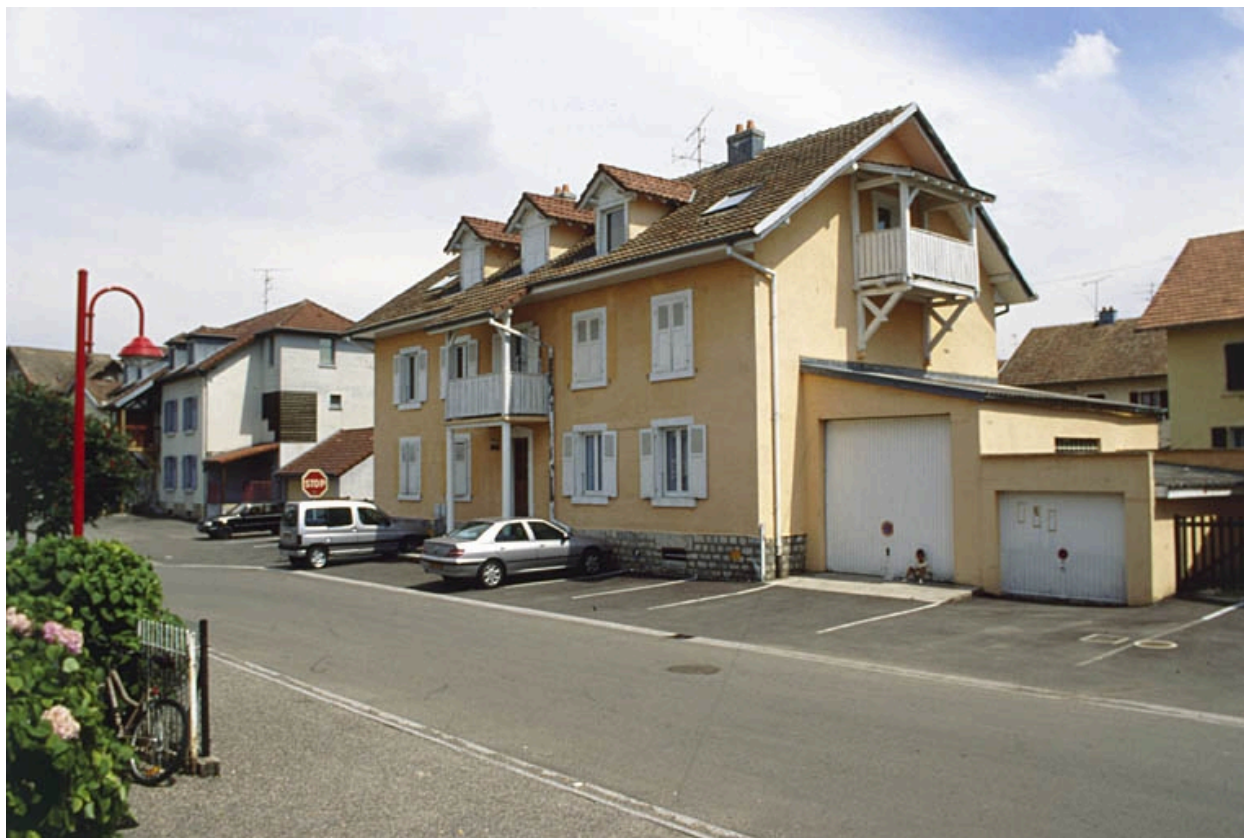
Logements collectifs rue Kléber.
