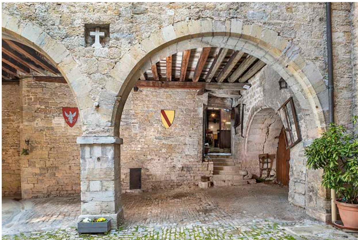
Arcades du passage couvert nord.
