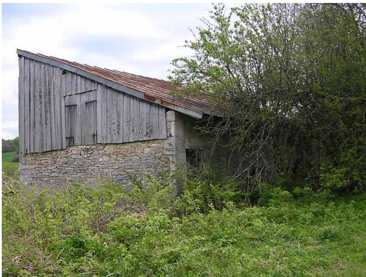
Vue générale du pignon nord-est.
